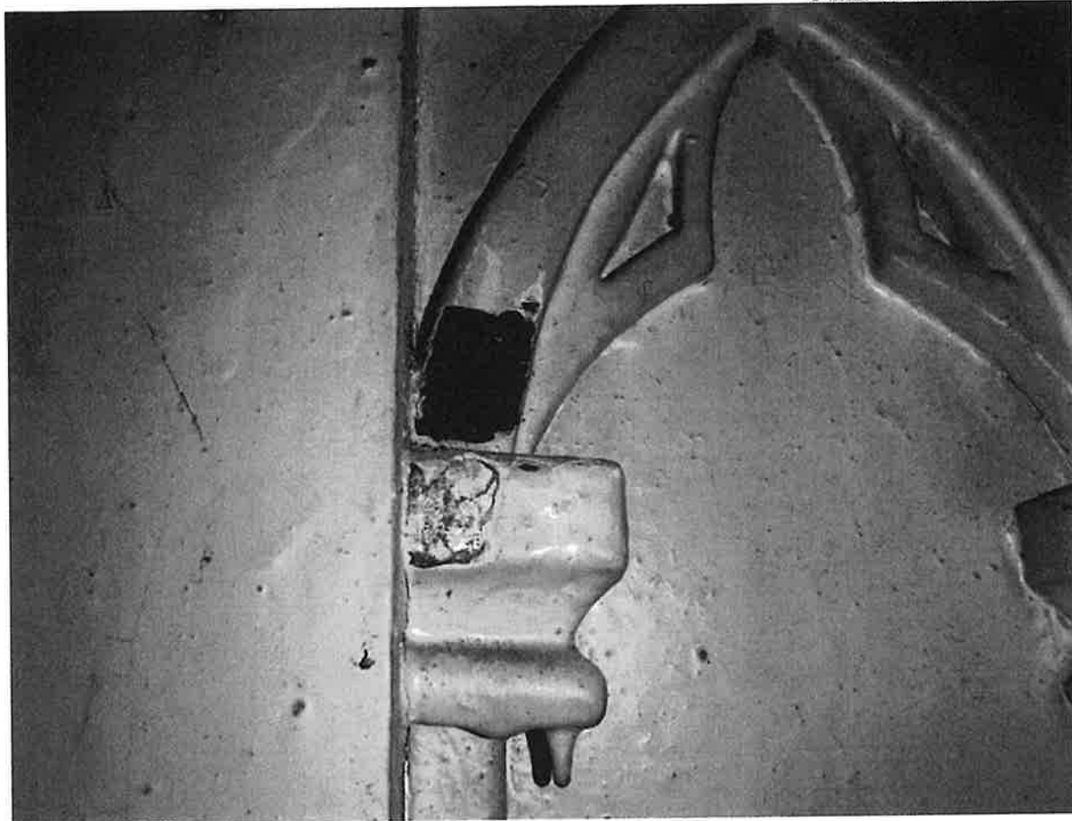
Obudowa okna architektonicznego między prezbiterium a kaplicą boczną
