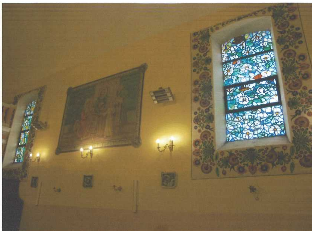
7. Ściana pn nawy- stan obecny
