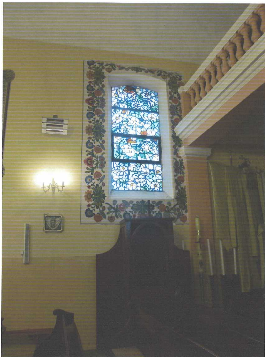
6. Okno zachodnie w południowej ścianie nawy- stan obecny
