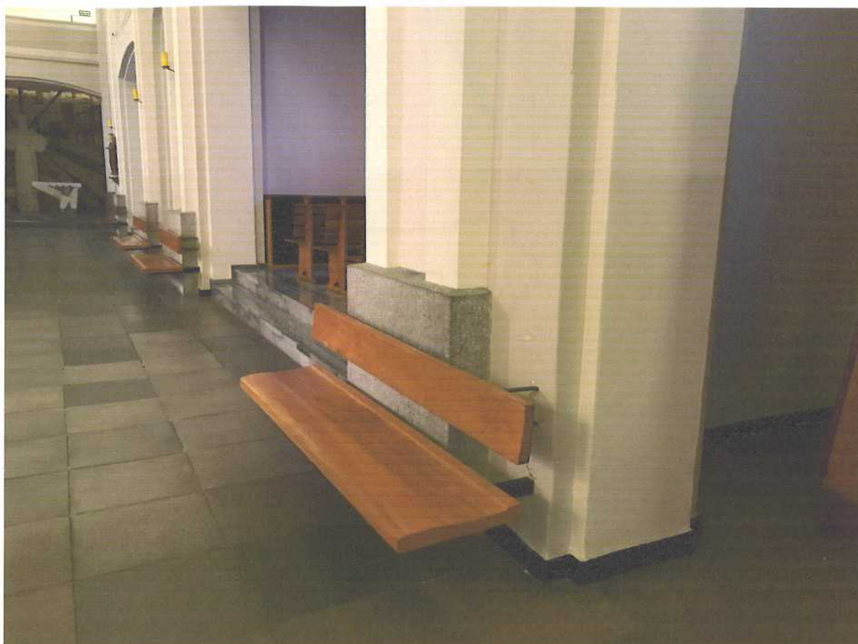
16. Przykład pokrycia strefy lamperii lakierem bezbarwnym, Toruń, kościół pw. Św. Józefa
