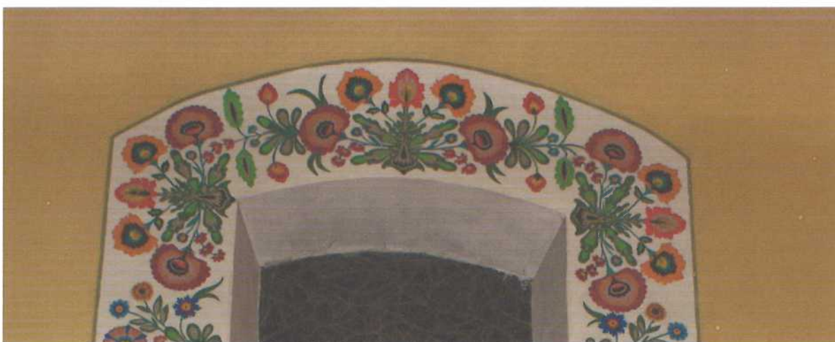
14 . Zwieńczenie bordiury okna w nawie- stan sprzed remontu 2012 r.
