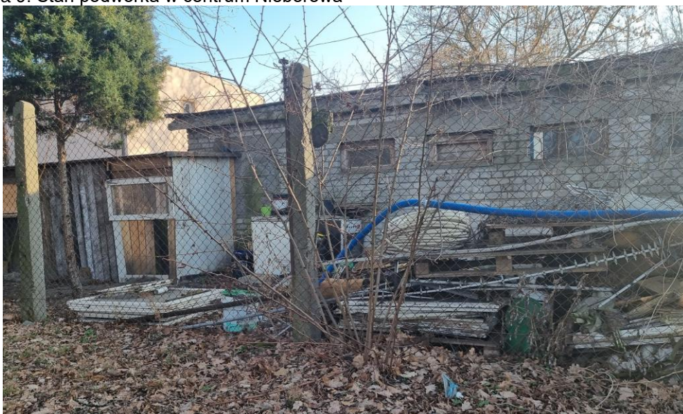
Fotografia 9. Stan podwórka w centrum Nieborowa
